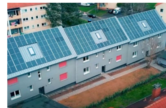
Immagini: ecoworks offre il suo Renovation Package per case plurifamiliari a 2 - 5 piani.
